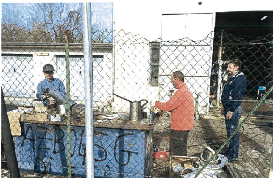
Continuano i lavori per pulire le condutture e all'impianto di via Einaudi
