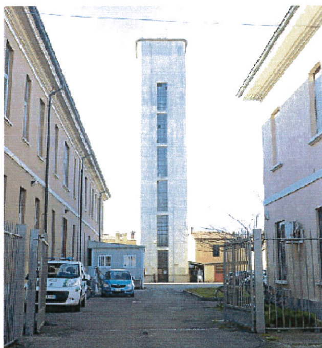
La torre dell'acquedotto che sarà abbattuta è stata costruita nel 1954
