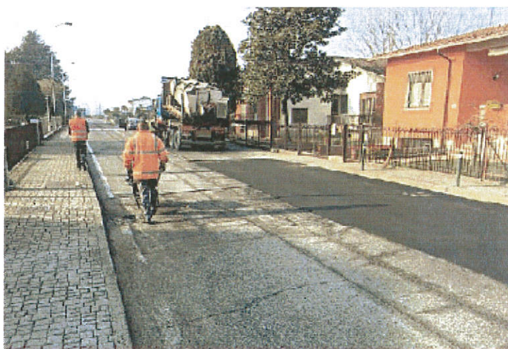
I lavori di sistemazione dell'asfalto nelle strade di Villanterio
