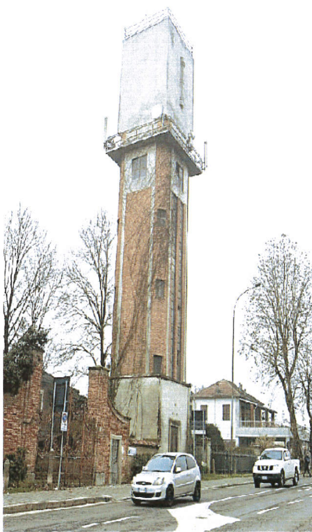
La torre dell'acquedotto di Belgioioso: la gestione passa a Pavia Acque
