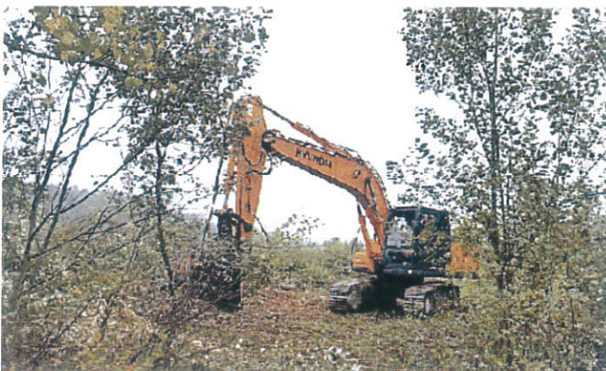
Una ruspa al lavoro lungo il tracciato della vecchia ferrovia
