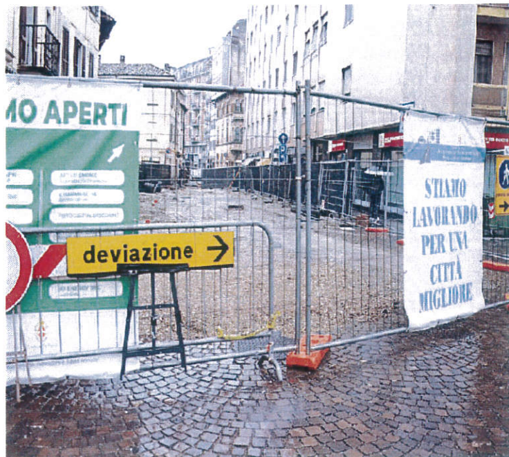
Il primo lotto del cantiere di corso Cairoli doveva chiudersi il 20 ottobre e dal 21 doveva partire il secondo
