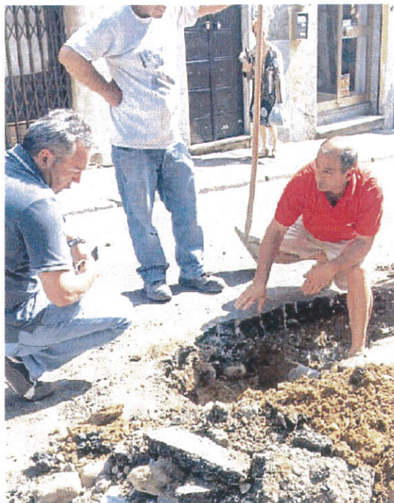
Interventi sulla rete fognaria a Stradella
