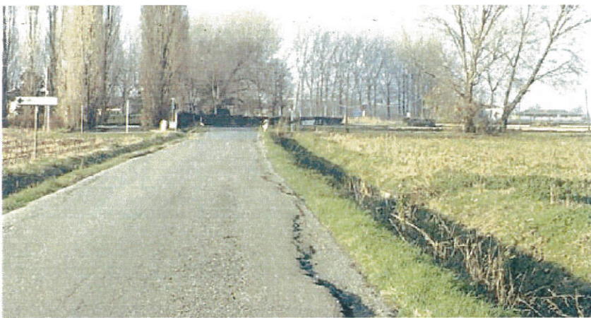
Nei progetti rientrano anche la sistemazione della provinciale e lavori per la sicurezza del ponte sul Lambro
