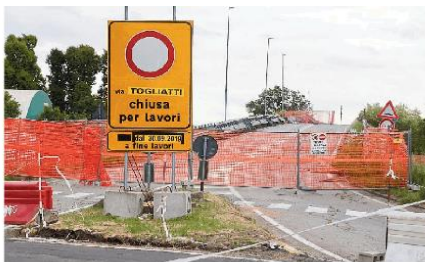
Il cantiere del cavalcavia Togliatti riaprirà lunedì prossimo: lavori in corso sino a settembre
