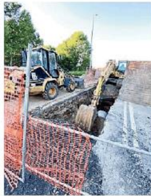
Il cantiere di corso Aldo Moro
