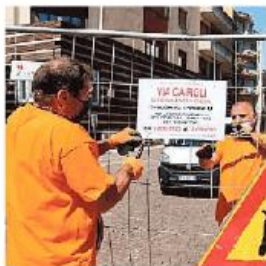
Operai al lavoro in via Cairoli
