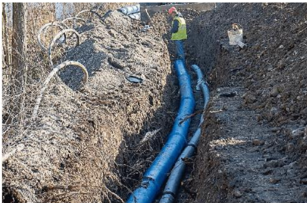
Un cantiere per la realizzazione di una rete idrica: Pavia Acque vuole avviare un piano da 20 milioni annui
