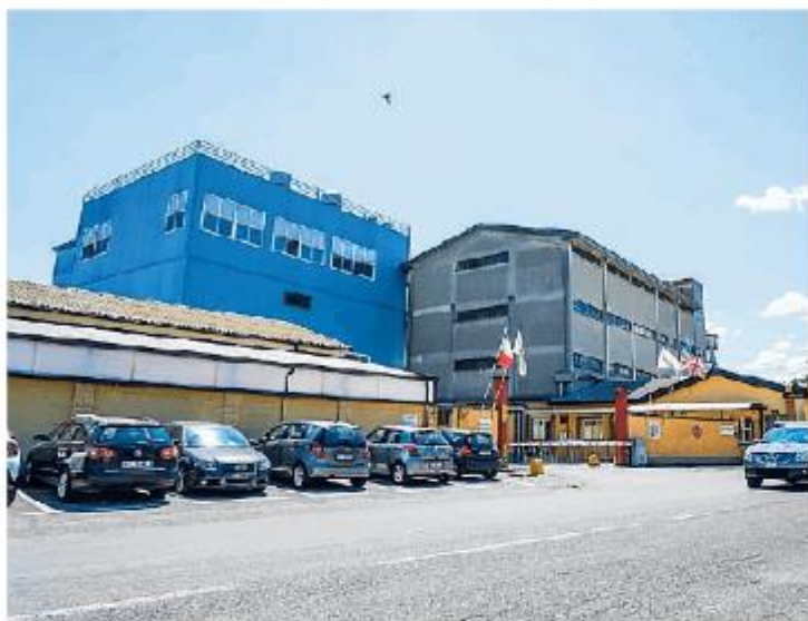
La Finanza di fronte all'impianto di depurazione
