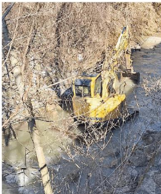
Presto nuovi lavori anche nell'alveo del torrente Coppa
