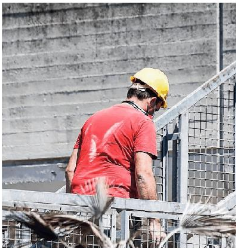
Presto al via i cantieri per il rifacimento degli acquedotti
