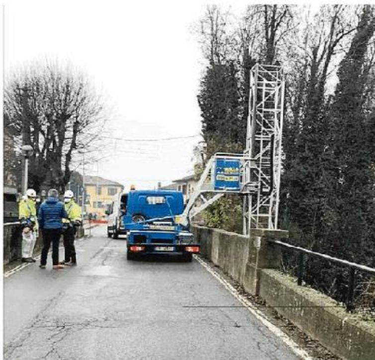
Verifiche al ponte che si trova nel tratto interessato dai lavori
