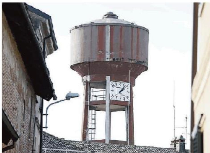
Il serbatoio pensile che dovrebbe essere abbattuto
