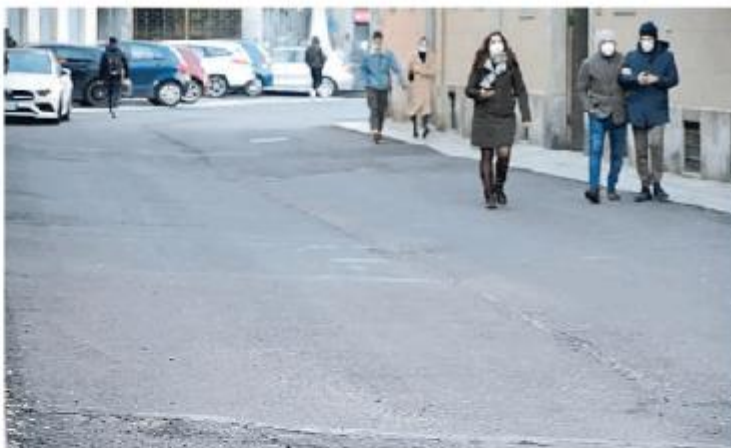
Corso Cairoli asfaltato: da marzo i lavori per il porfido
