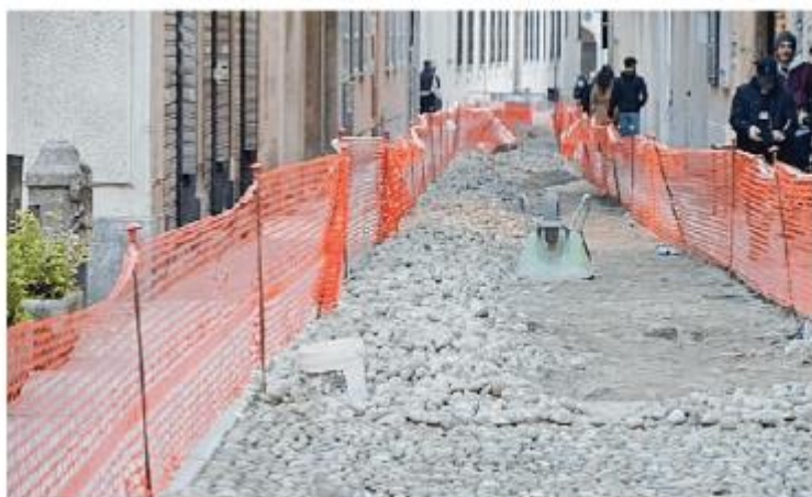
Il cantiere per sistemare l'acciottolato in via Siro Comi
