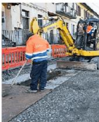
Lavori in via Milazzo
