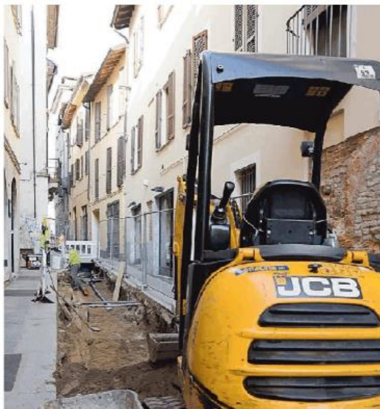
Lavori in corso in via dei Liguri
