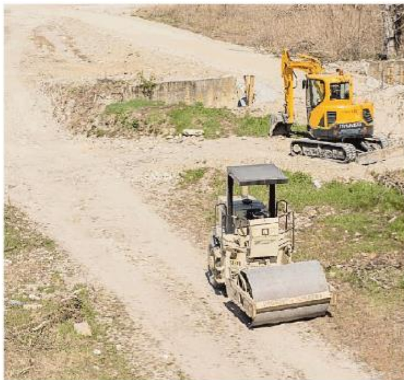
Le ruspe preparano il tappeto per la prossima asfaltatura
