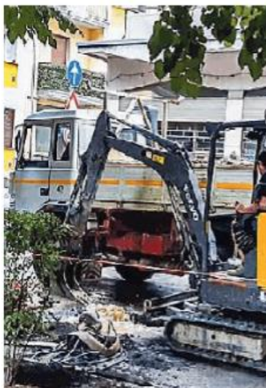
I lavori alla rete idrica
