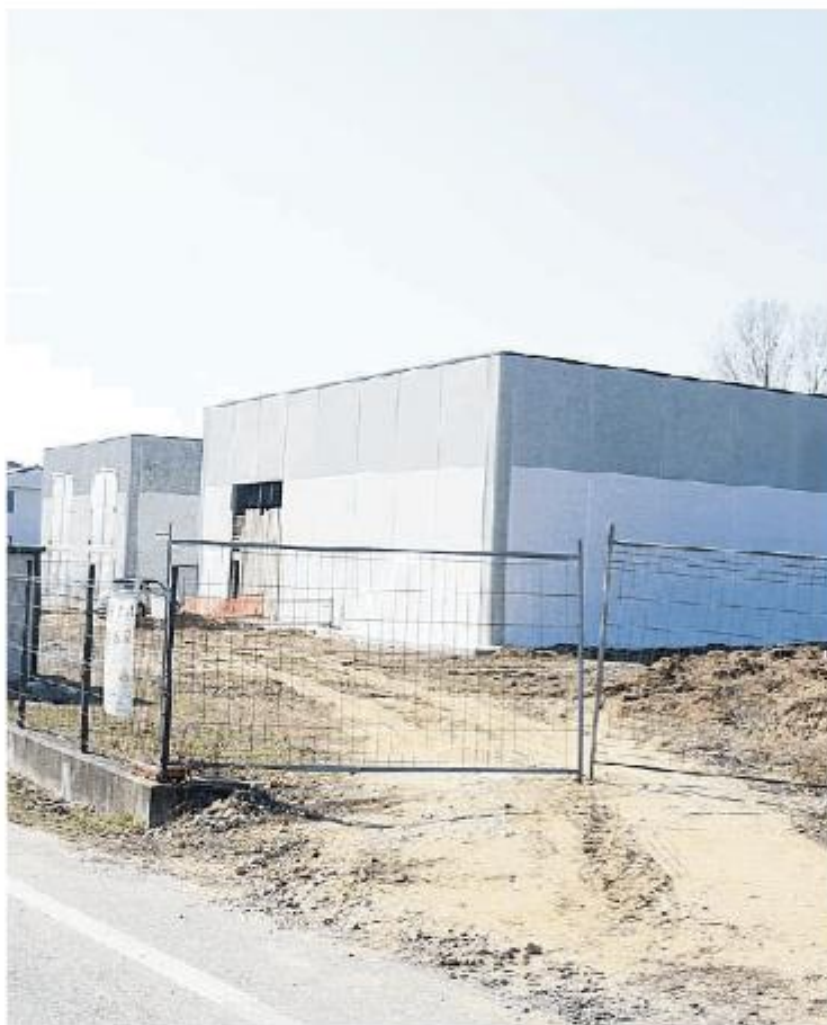
I nuovi impianti dell'acquedotto a Cava Manara: sette anni di lavori
