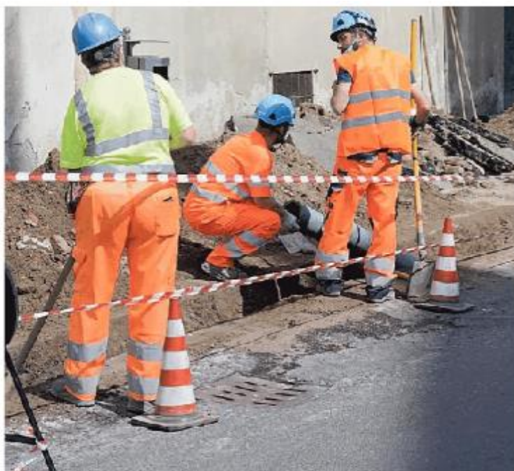
Proseguono i lavori in corso Cairoli, cominciati nel 2019
