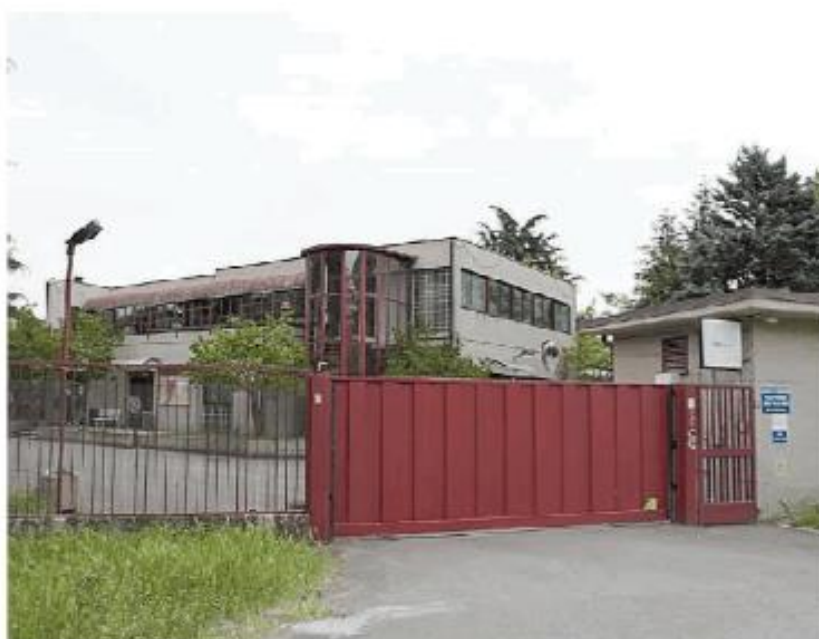
Il depuratore di Pavia Acque si trova in via Montefiascone al civico 25
