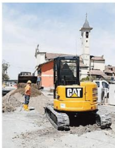
I lavori in corso a Balossa Bigli
