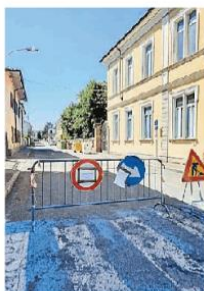
Il cantiere di via Umberto I
