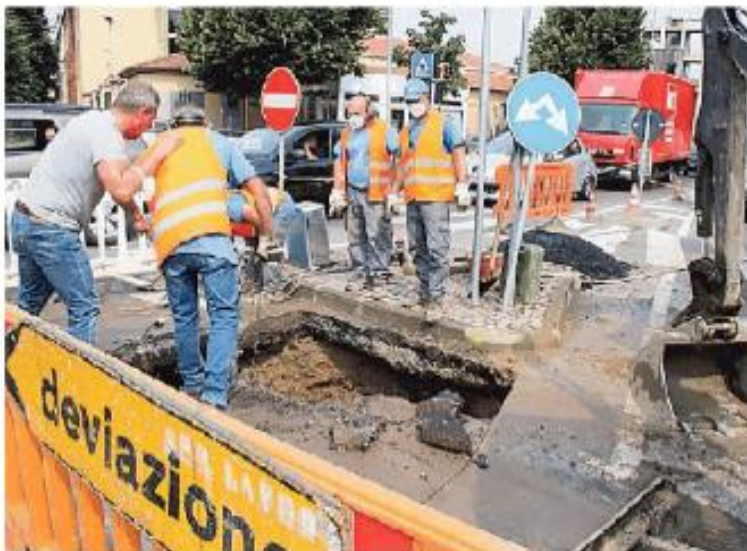
L'intervento sull'acquedotto in via San Paolo
