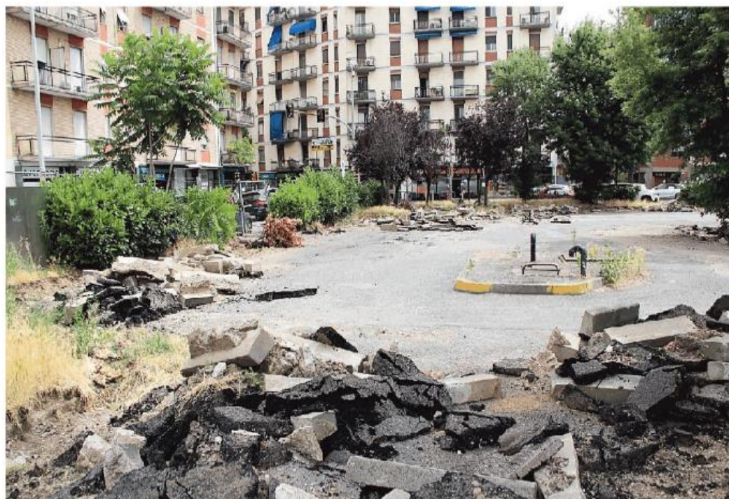
Il cantiere di piazzale San Giuseppe: al centro della foto si può notare il pozzo di Pavia Acque e sul perimetro i marciapiedi già demoliti
