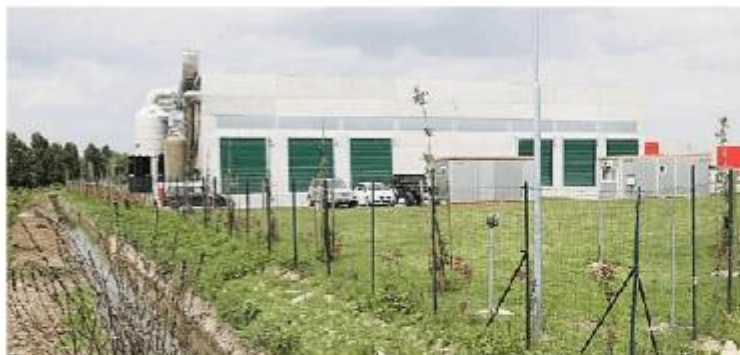
L'impianto di Agririsorse, nella zona industriale di Mortara
