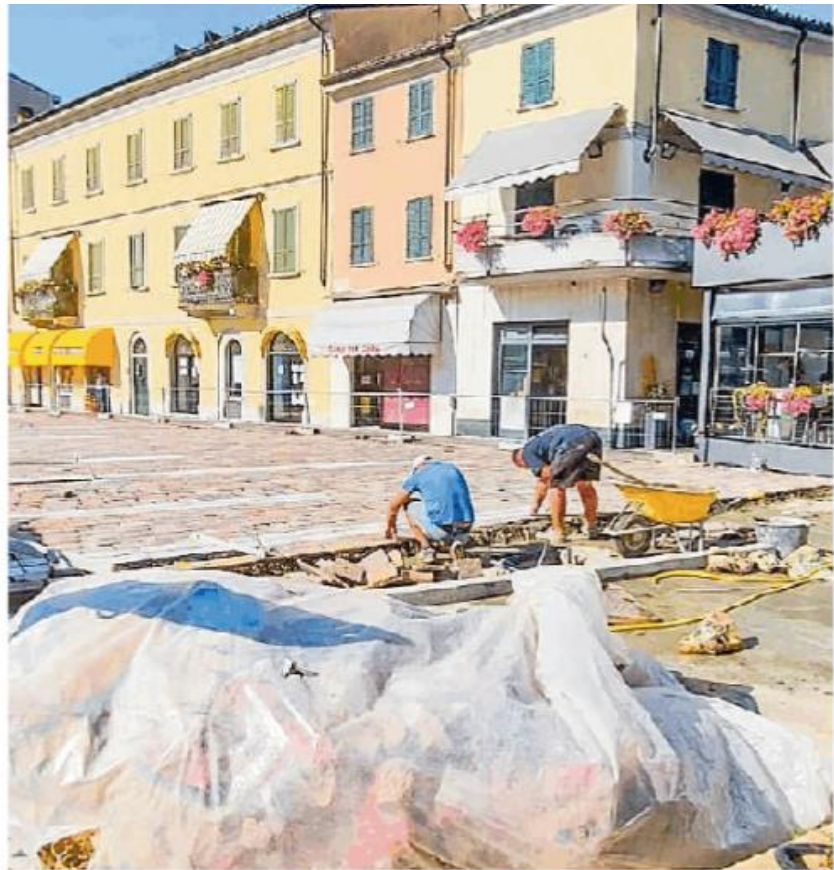
Il cantiere aperto da alcuni giorni all'area Rondò di piazza Trieste
