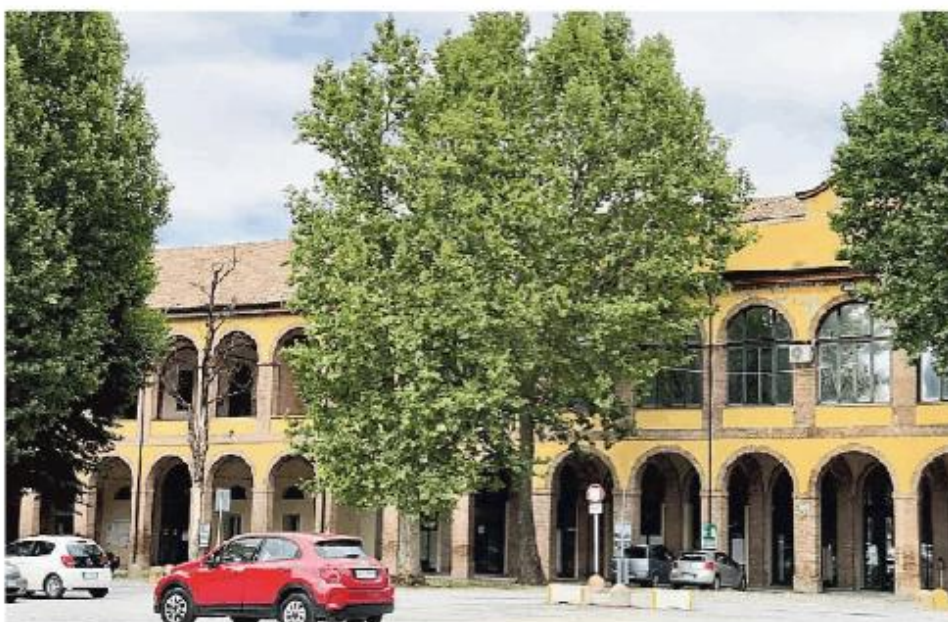
L'ex caserma di cavalleria. Il Pgt ne prevede il recupero completo per interventi di qualità
