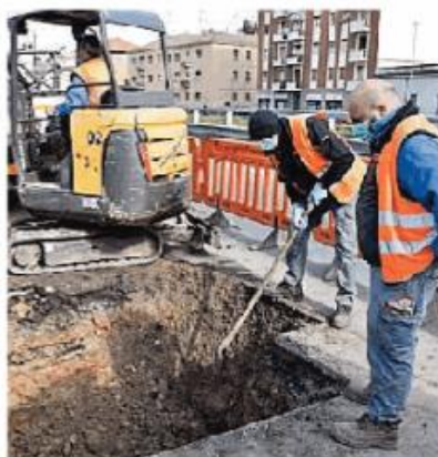
Intervento su una perdita
