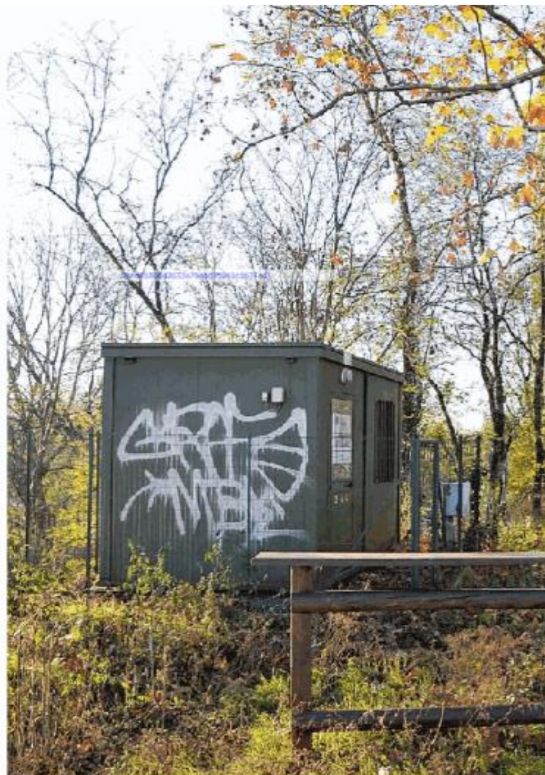
Il pozzo in zona Ticinello che serve l'area di Borgo Ticino
