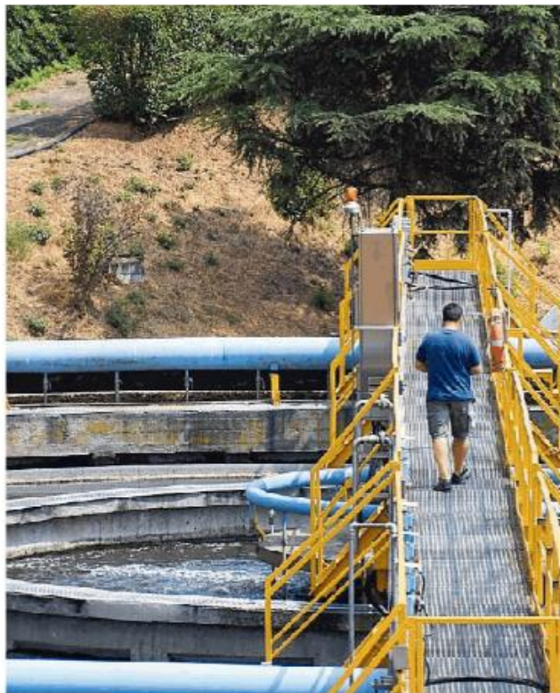
Il depuratore di Montefiascone: anche i suoi fanghi finiti nell'inchiesta
