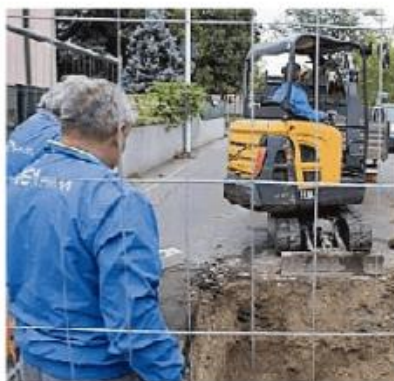
Il cantiere in via Fasolo
