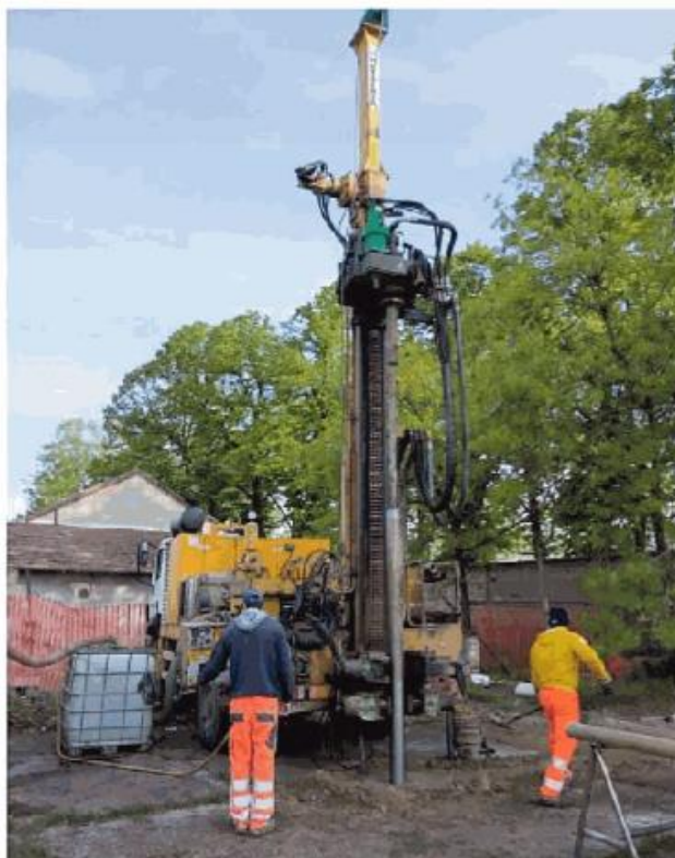
Carotaggi nell'area ex Necchi in cerca di inquinanti
