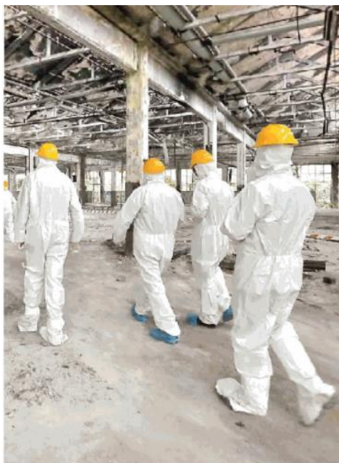
Sono in corso le operazioni di bonifica della falda sull'area ex Necchi
