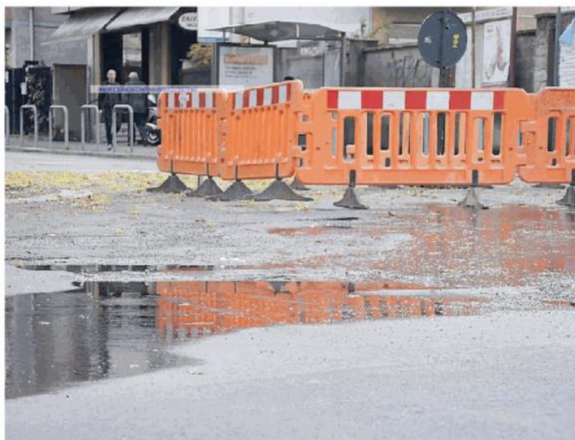
I liquami che si sversano anche in strada dopo il blocco della stazione di sollevamento. A destra, gli interventi già iniziati per trovare il cedimento principale
