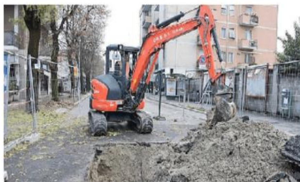
Ruspa al lavoro in via San Paolo dopo il cedimento della fognatura
