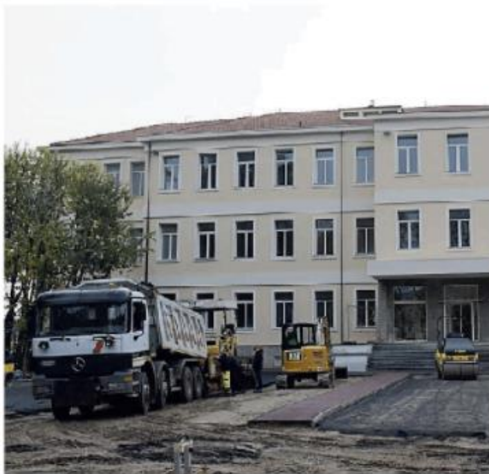
Ultimi interventi per completare la nuova sede di Pavia Acque
