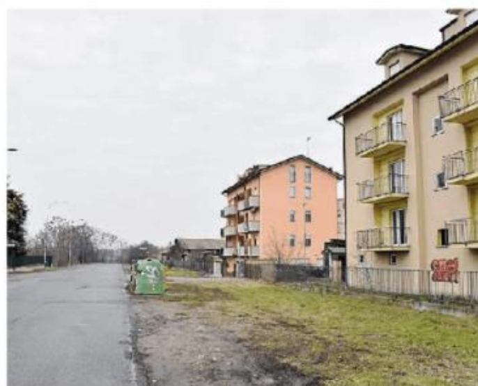
L'area edificata in via Don Lorenzo Milani
