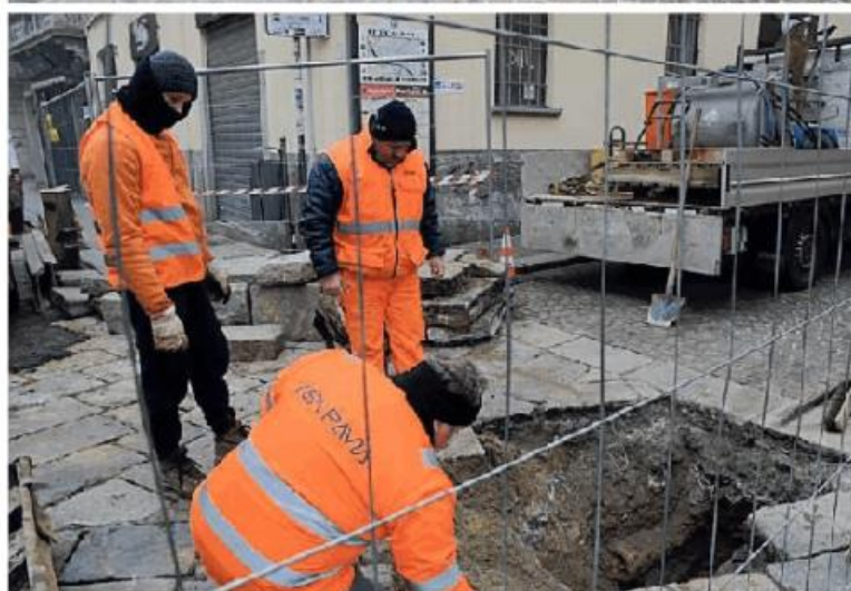
La squadra di Asm Pavia al lavoro tra corso Cavour e Strada Nuova
