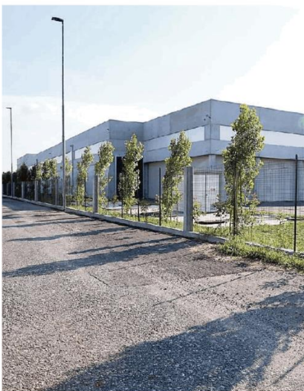
L'impianto di Agrisorse, azienda di trattamento dei fanghi
