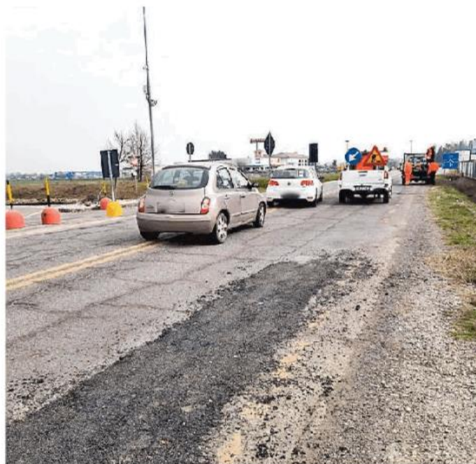
L'intervento di asfaltatura provvisoria per la Milano-San Remo
