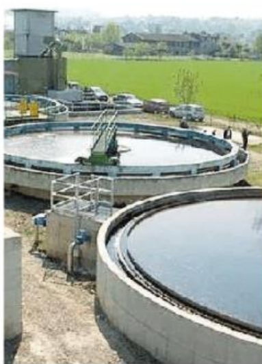
Un nuovo depuratore in provincia
