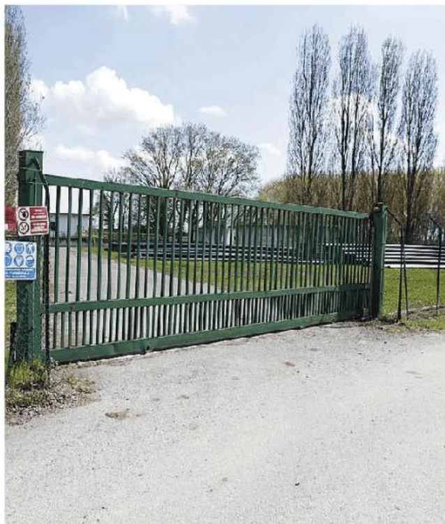
Il depuratore di Sannazzaro verrà potenziato da Pavia Acque
