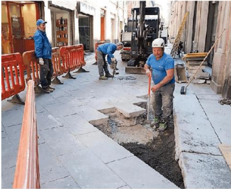
Operai dell'Asm al lavoro per riparare le condotte danneggiate
