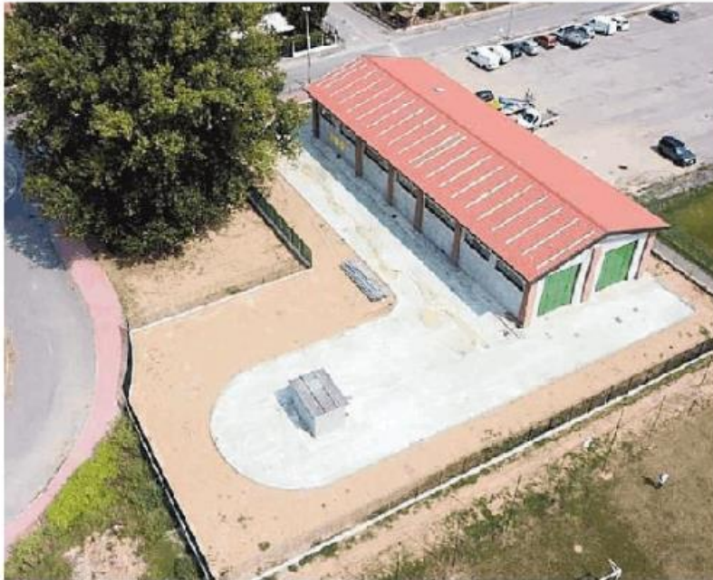
La nuova centrale di potabilizzazione a Giussago
