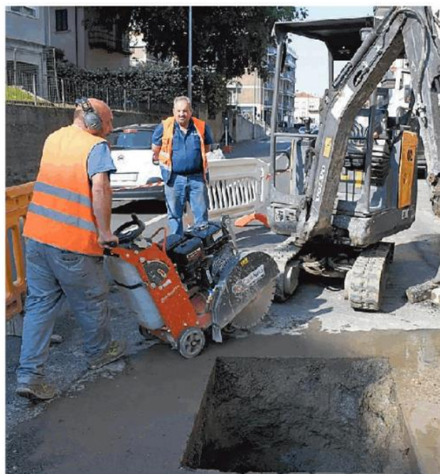
L'intervento dei dipendenti di Asm sull'acquedotto in via Fasolo
