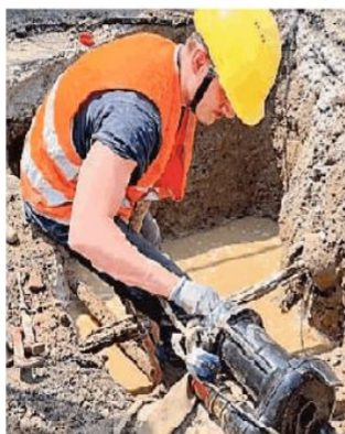
I lavori di ripristino della perdita
