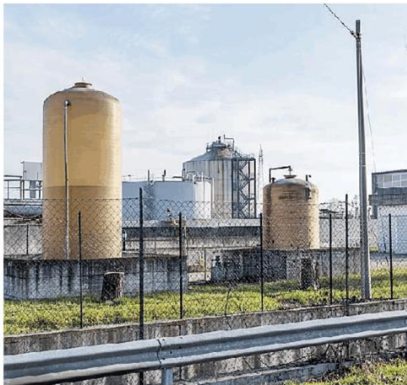
A.ALF. L'impianto di via Postiglione a Voghera
