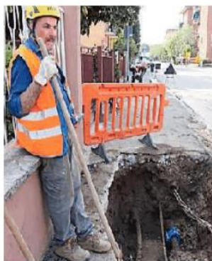
Il cantiere di via Folperti
