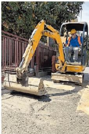
Il cantiere di via Folperti
